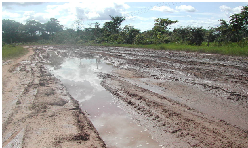
Foto 01 – TRECHO DA BR 422 EM CAMETÁ: uma das possibilidades de deslocamento alternativo ao rio em Cametá, mas que, devido às péssimas condições de trafegabilidade, tem uma utilidade muito restrita para a população (Foto: José Carlos Cordovil, Janeiro/2004)
